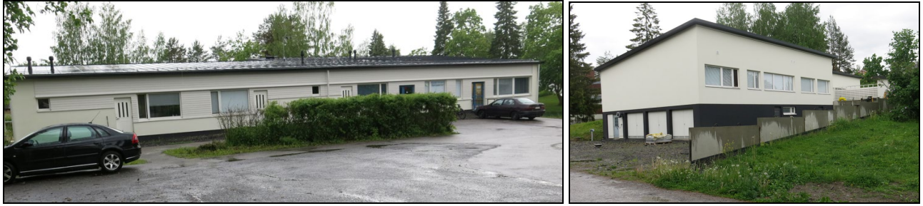
Entinen terveystalon punatiilinen julkisivu on rapattu vaaleaksi ja kellarikerros tummaksi. Kuva v. 2025
